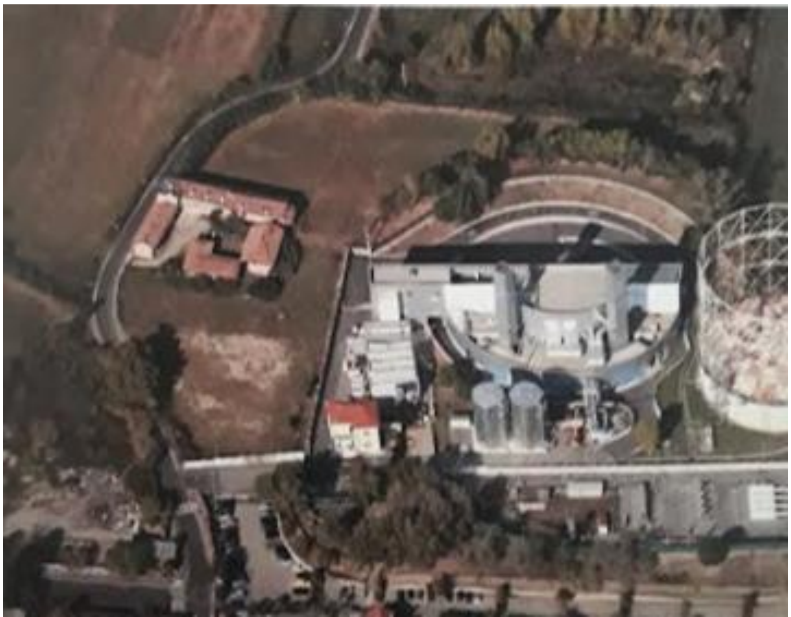
Cascina Sant'Ambrogio e il gasometro oggi
